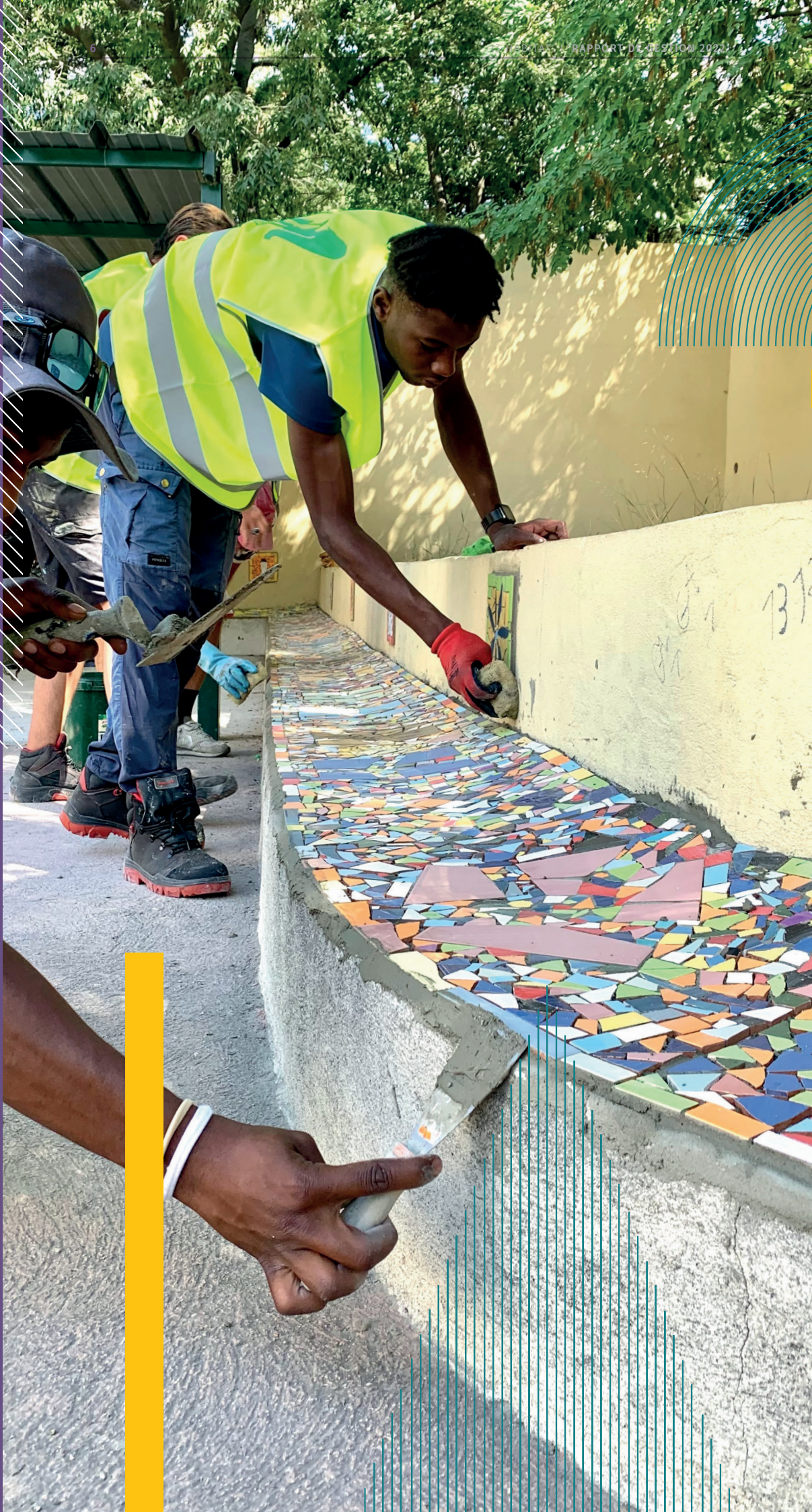
Chantier d'inclusion sociale TAPA, résidence Chemin de Fer (Marseille 4e)
